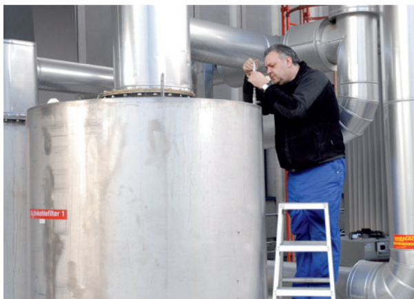
Abb. 2 Einfache Probenahme durch den Betreiber vor Ort
